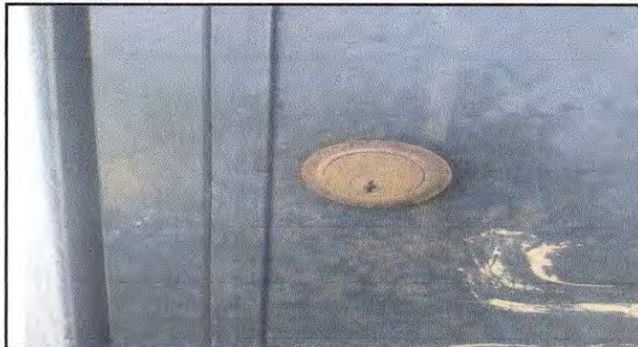
Foto 1: Lijado y aplicación de pintura
