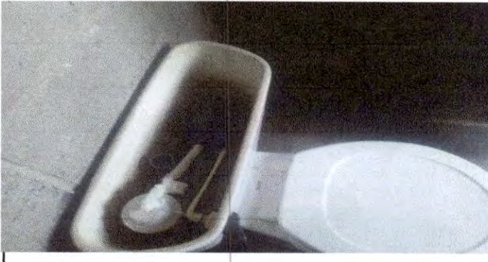
Foto 6: Instalacion de Inodoro
