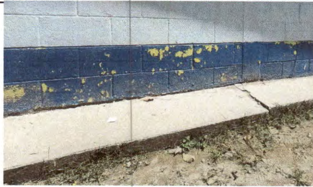
Foto 2 : Pintura en muros exteriores e interiores
